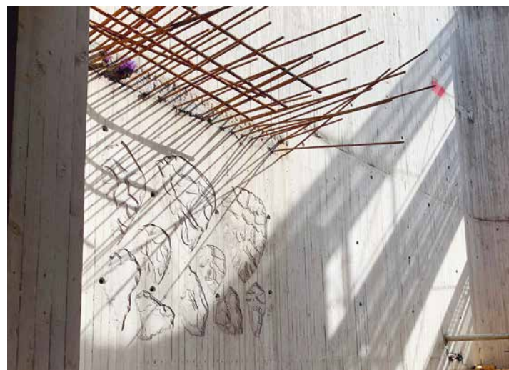
Baustelle Burghalde, 15. Mai 2019
